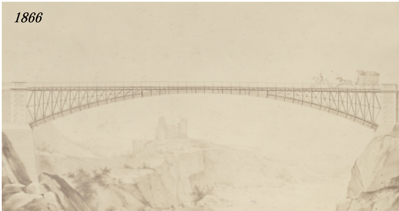
Pont-route de la rivière El Cinca en Espagne construit au Creusot
