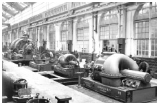
Hall d'assemblage des turbines à CM3 en 1910
