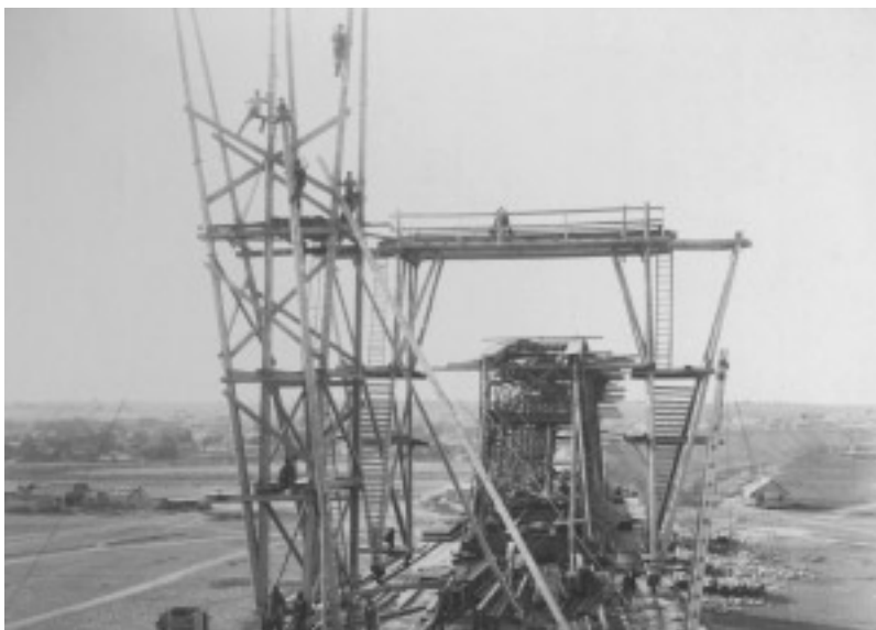
Pont sur la Borcea en cours de construction
